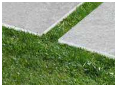
Colocación en seco sobre hierba, arena o gravilla Dry placement on grass, sand or gravel Pose à sec sur gazon, sable ou gravier
